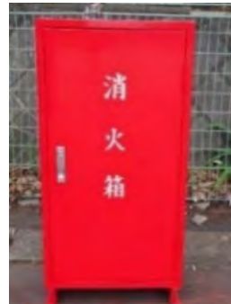
初期消火箱（固定式）
